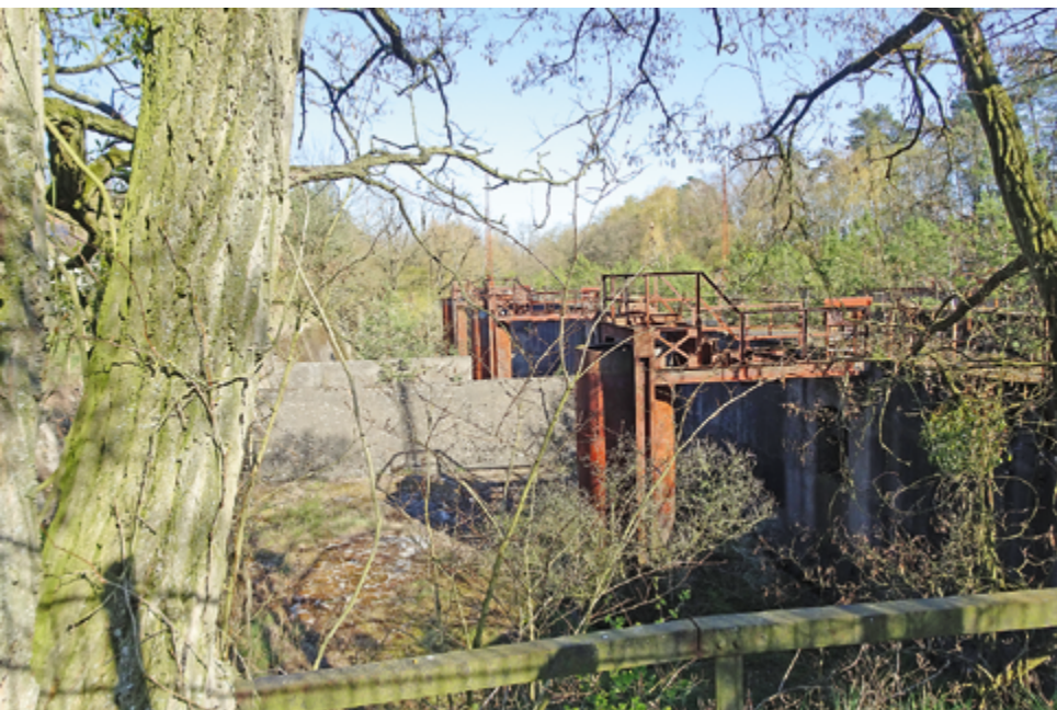
Zuwachsende Schleuse der alten Schleusentreppe
