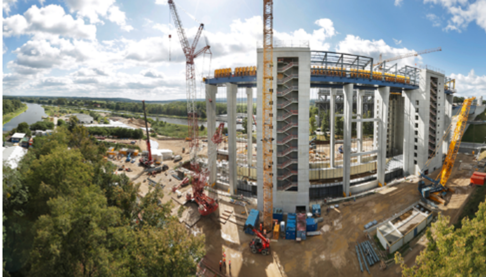
Neues Schiffshebewerk in der Bauphase
