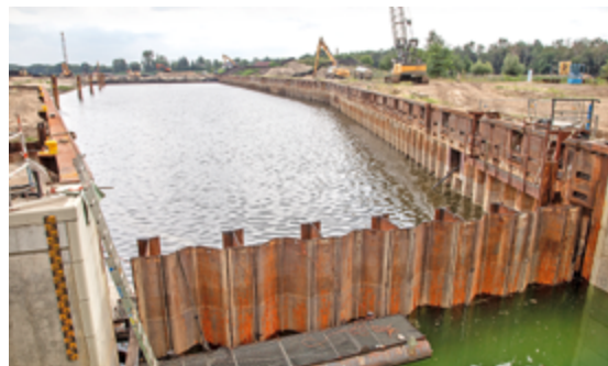
400 Meter lange Umschließung der Baugrube
