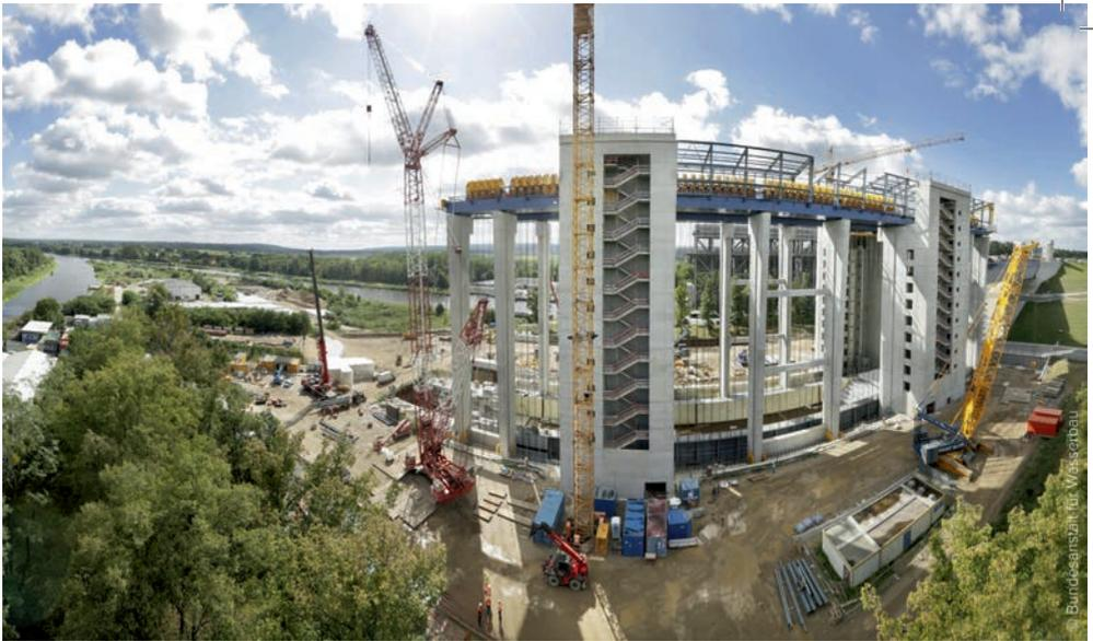
Zwei massive Türme und sechs Stützen wechseln sich auf beiden Seiten ab.
