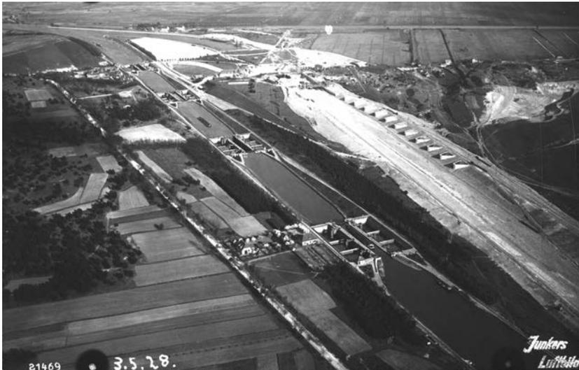
In vier Schleusenkammern überwandn Schiffe den Höhenunterschied von 36 Metern.
