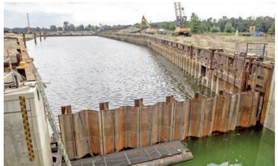
400 Meter lang ist die Umschließung der Baugrube.
