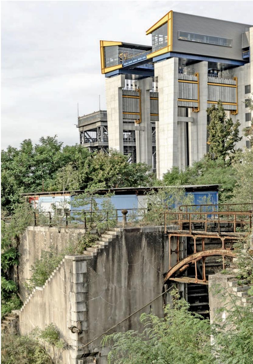
Wasserbautechnik aus zwei Jahrhunderten. Neben den Resten der Schleusentreppe erhebt sich das neue Schiffshebewerk.
