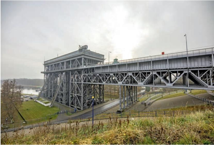
Im alten Hebewerk werden die Schiffe senkrecht gehoben.
